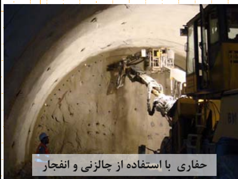
حفاری مکانیزه با استفاده از Road-header
