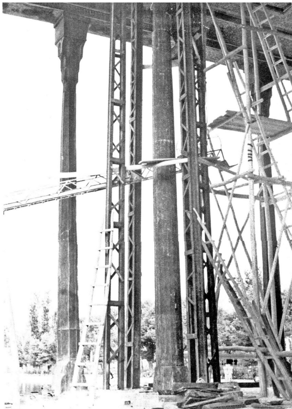
چهل ستون، اصفهان. استحکام بخشی بنا با جایگزینی ستون های فولادی در ستون های چوبی اصلی بنا. به کارگیری تکنیک های جدید در استحکام بخشی گاهی ضروری است.
