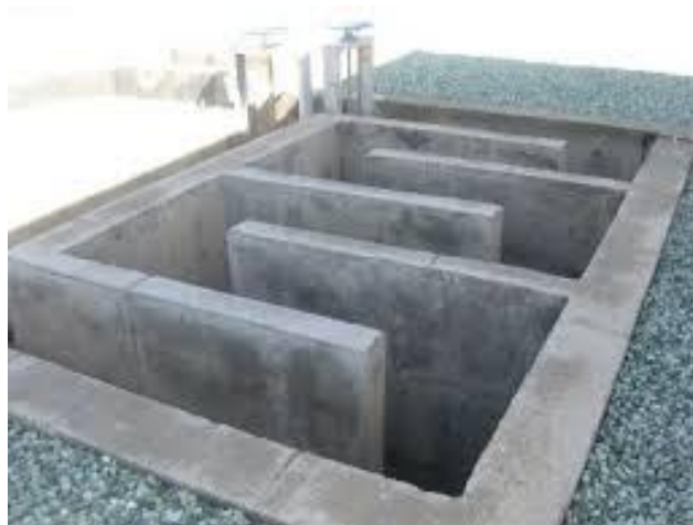
شکل 14- دیوارهای بتنی منحرف کننده جریان در حوضچه انعقاد و لخته سازی
