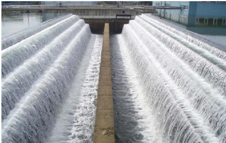
شکل 6- استفاده از برج های آبشاری در هوادهی آب
