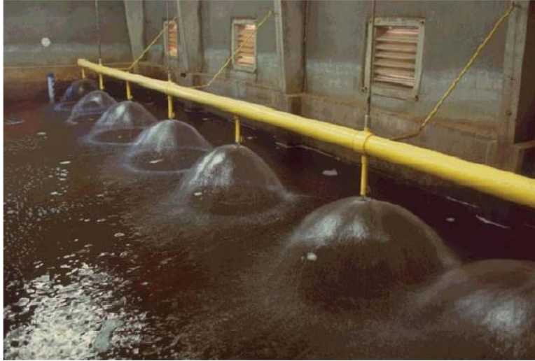
شکل 4- استفاده از فواره ها در هوادهی آب
