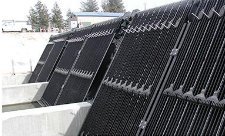
شکل 25- واحد آشغال گیری با پاکسازی مکانیزه
