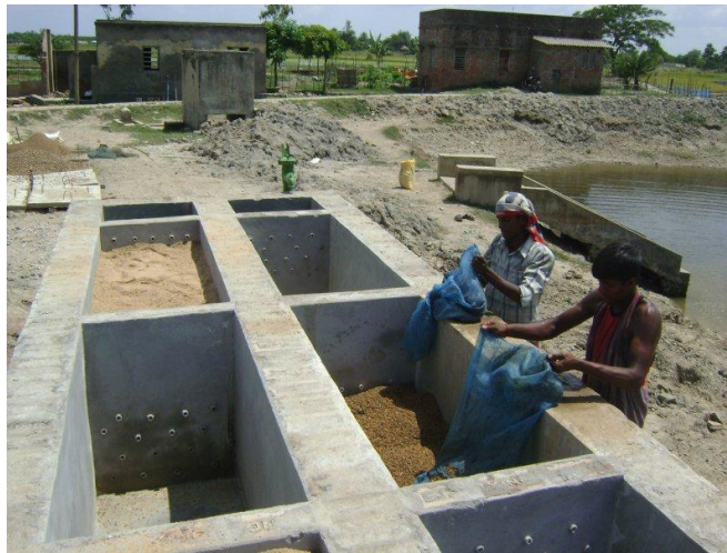
شکل 31- پر کردن حوضچه های بتنی صافی ماسه ای کند با شن و ماسه
