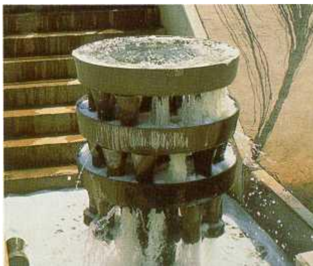
شکل 7- استفاده از برج های سینی دار در هوادهی آب
