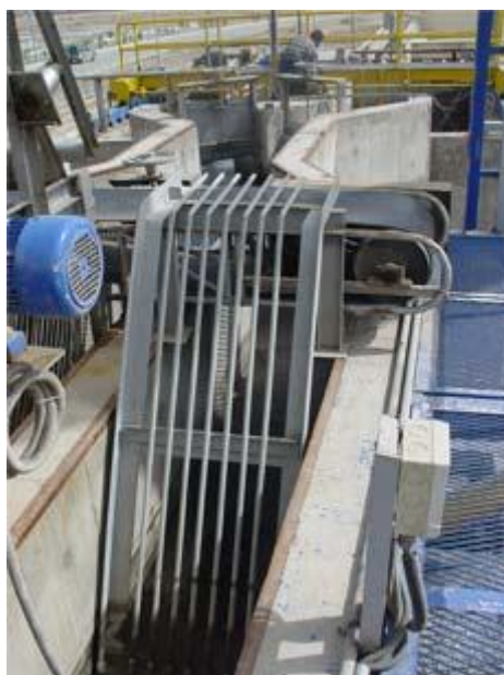
شکل 24- واحد آشغال گیری با پاکسازی دستی
