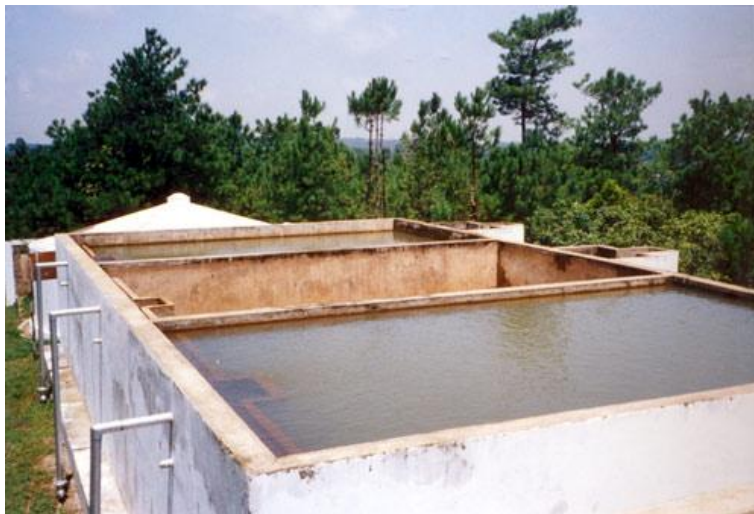
شکل 32- صافی ماسه ای کند در حال بهره برداری
