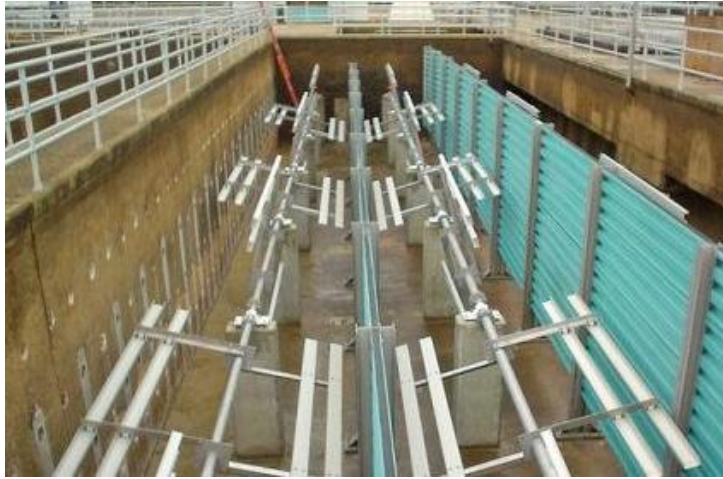
شکل 18- استفاده از همزن های پارویی در حوضچه انعقاد و لخته سازی
