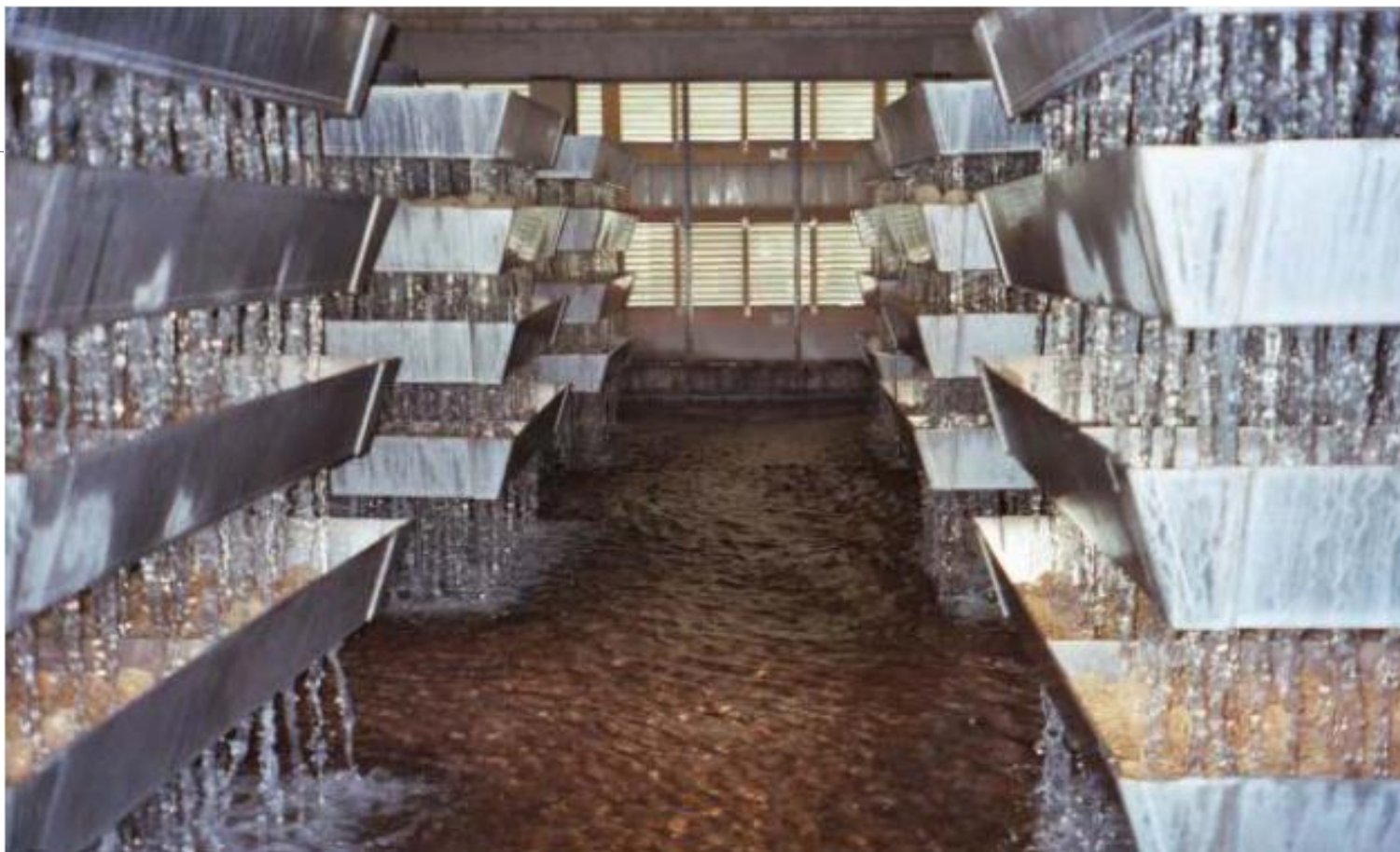
استفاده از برج های سینی دار در هوادهی آب
