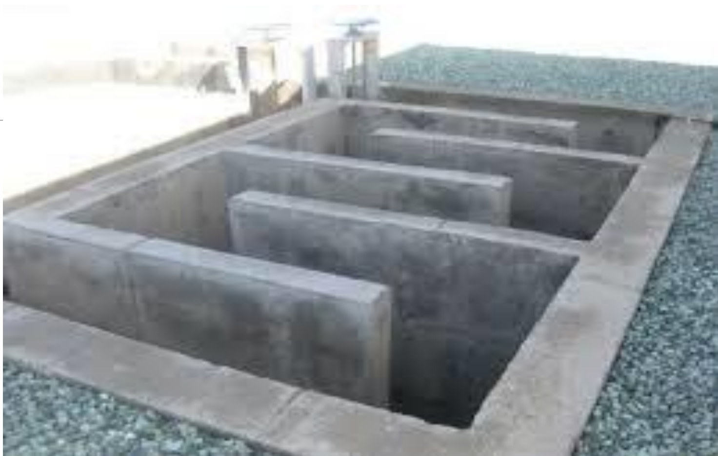
دیوارهای بتنی منحرف کننده جریان در حوضچه انعقاد و لخته سازی
