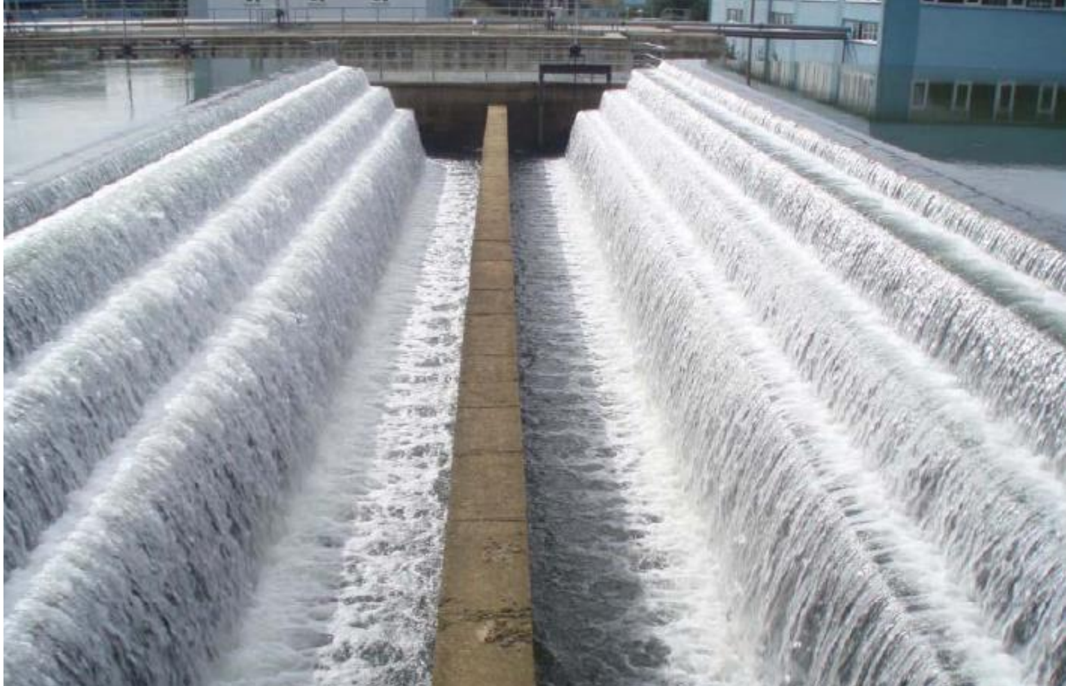
استفاده از برج های آبشاری در هوادهی آب
