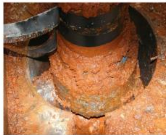
ایجاد رسوب روی لوله مکش پمپ آب از چاه
