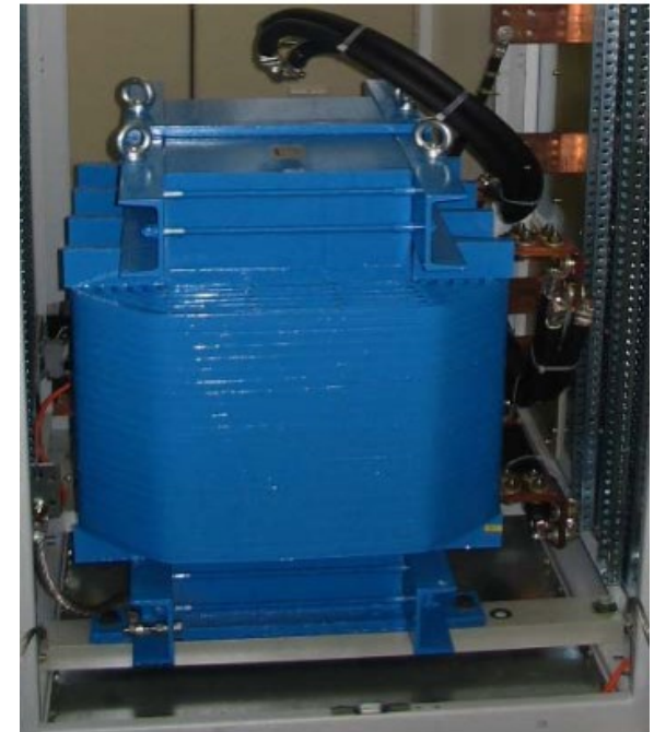
راکتور DC سیستم SFC
