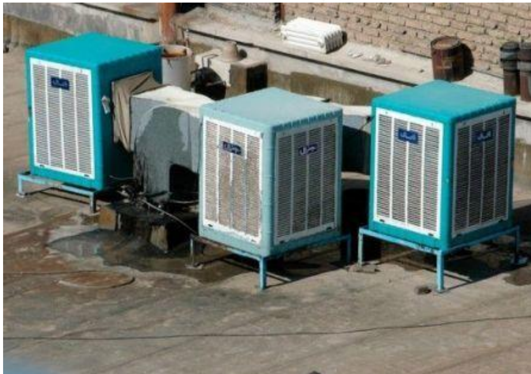
(ب) کولرهای آبی معمولی با موتور تکفاز القایی
